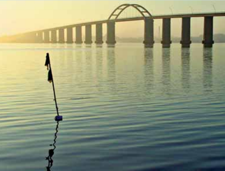
Aftenstemning over Langelandsbroen og bæltet.
